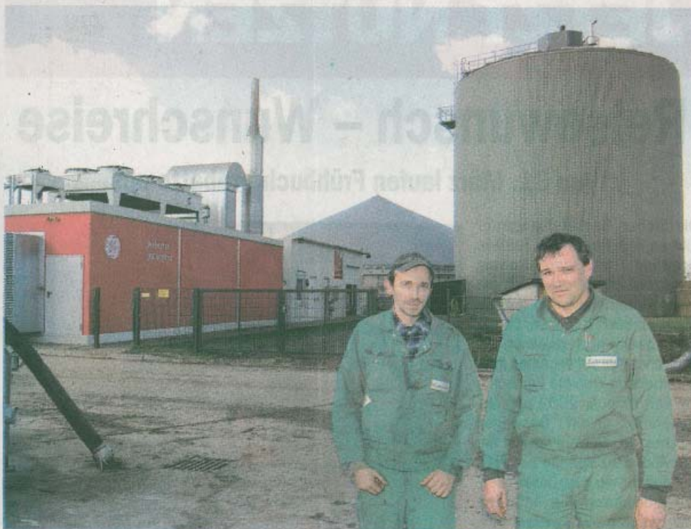
Sie halten die Biogas-Anlage am Laufen und freuen sich, dort arbeiten zu können: Jörg Wunderlich und Kai Siebeneich (v.l.). Foto: Vogt
