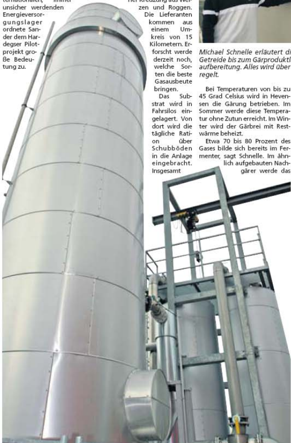
Hoch hinaus ragt die Gasaufbereitungsanlage: Das Rohgas wird aufbereitet und der Erdgasleitung zugeführt.
