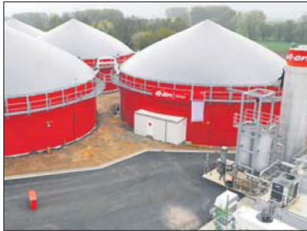
Jahresleistung in Hevensen: 45 Millionen kWh Rohbiogas. CM
