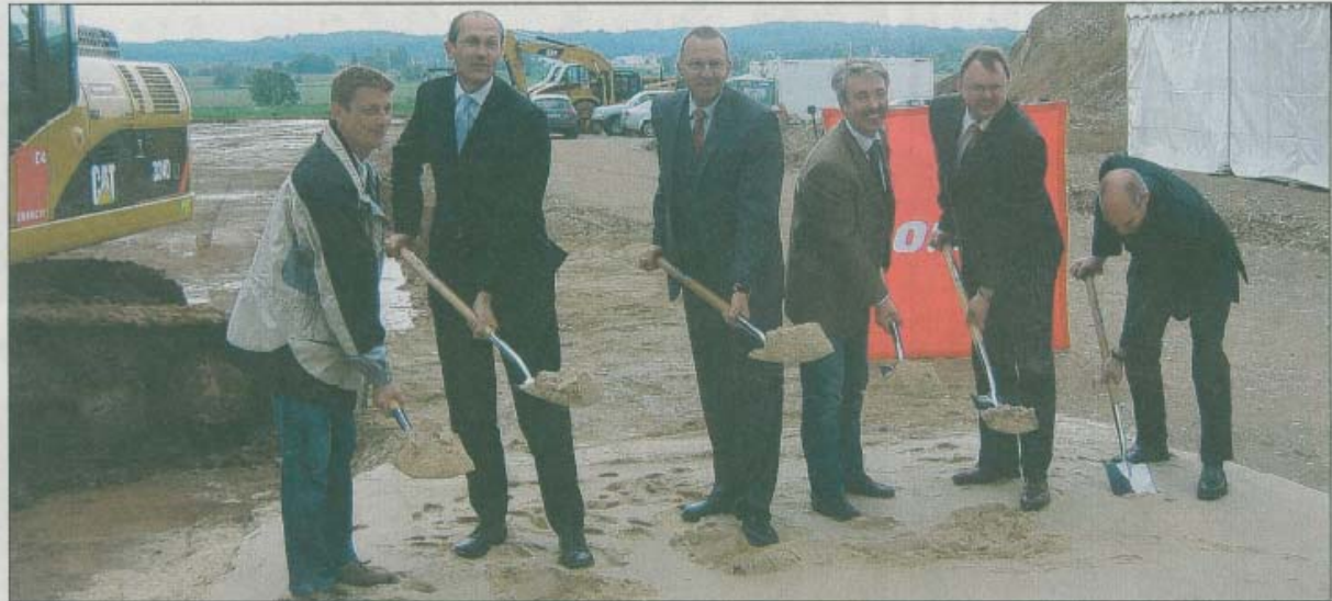
Mit Freude bei der Arbeit war Landwirt Martin Klarmann (links) von der Anbauvereinigung Altenstadt. Für Landrat Joachim Arnold und Bürgermeister Norbert Syguda (Mitte) ist ein erster Spatenstich längst Routine. Foto: Giers
