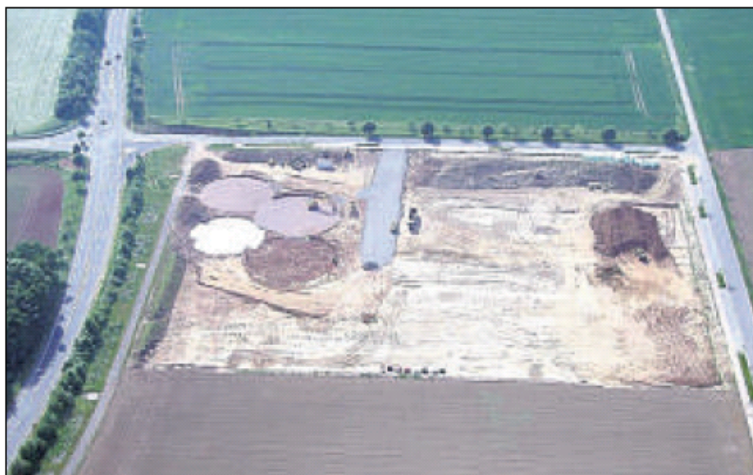
Noch leer und öd: Auf 30 000 Quadratmetern entsteht die Anlage. Auf der linken Seite ist die B446, die Abfahrt links führt Richtung Gladebeck.
