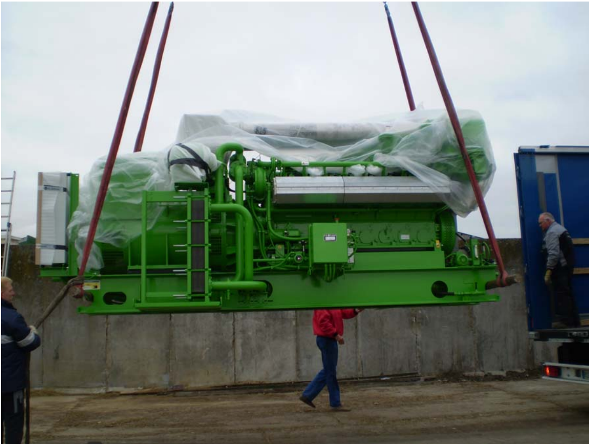
Das neue Blockheizkraftwerk wird geliefert und eingebaut.
