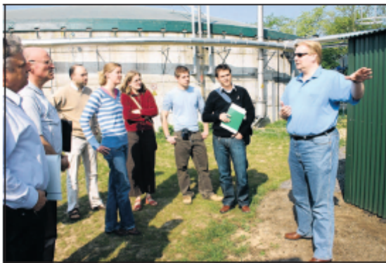
In Bobitz erklärte Olaf Bockholt (r.), wie die Biogasanlage mit Gülle aus dem Kuhstall und Mais vom Feld Strom und Fernwärme macht. Foto: T. V.
